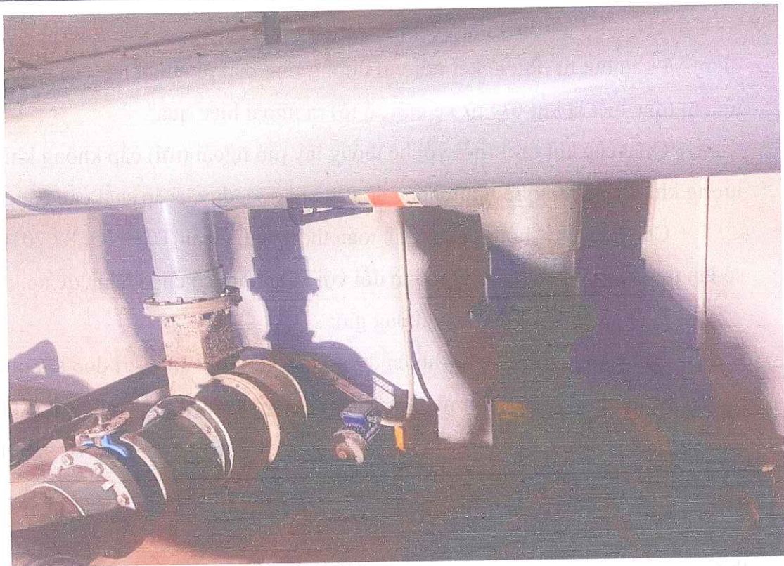
Hình 3.14. Hình ảnh quạt ly tâm hút mùi tại trạm XLNT
