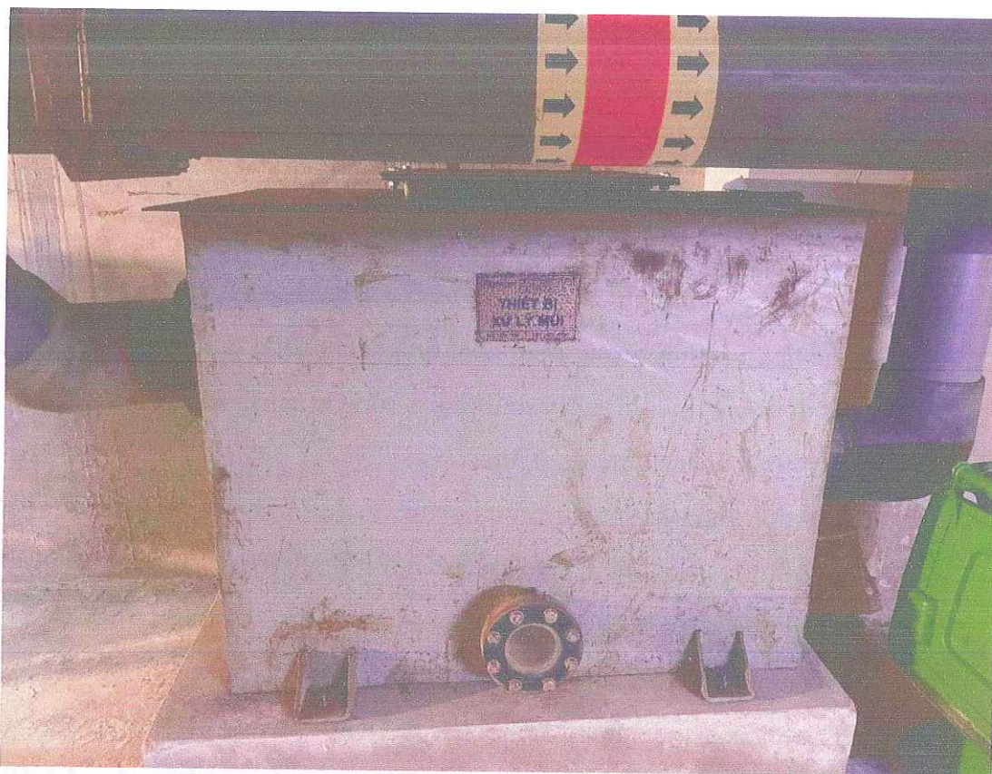
Hình 3.13. Hình ảnh hệ thống xử lý khí thải (mùi) phát sinh tại trạm XLNT
