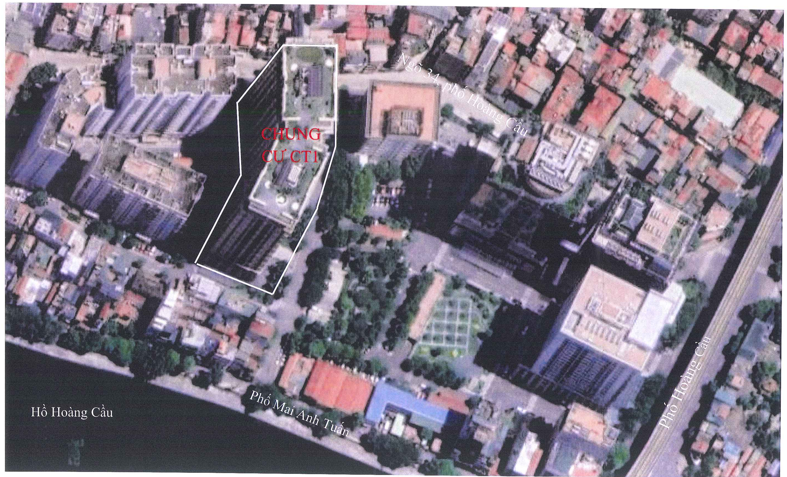
Hình 1.1. Hình ảnh vệ tinh của chung cư CT1
